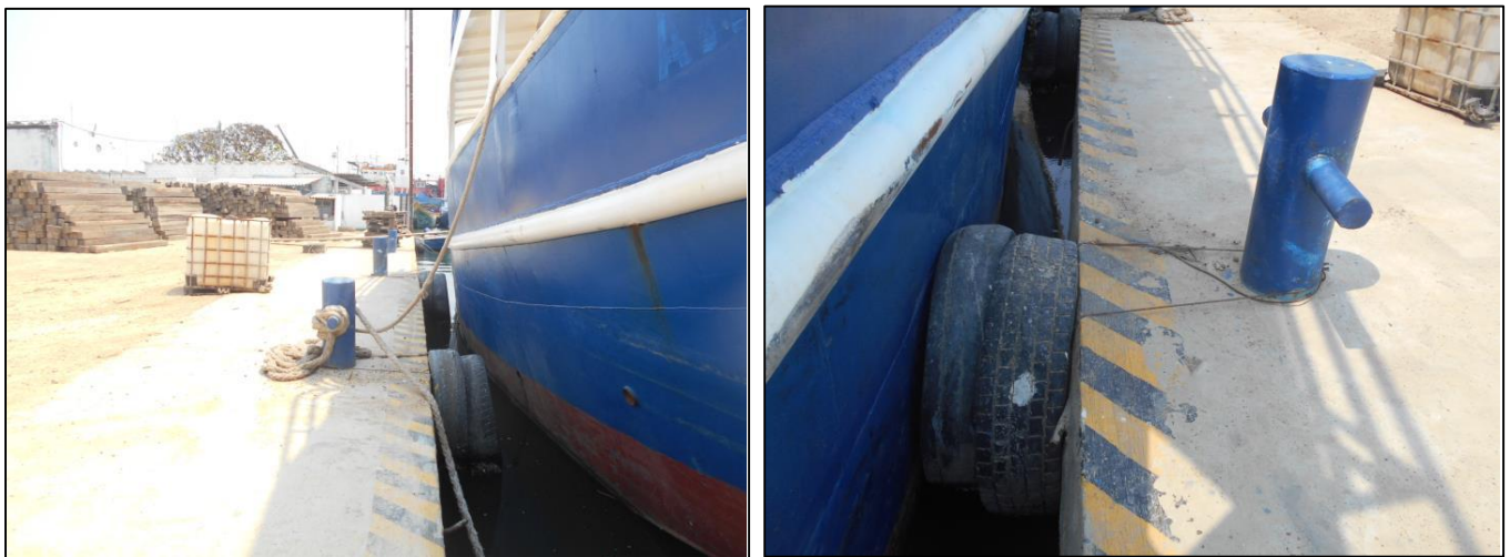
Fotos 1 y 2. Vista características del muelle y bitas de la I.P. BITA R.M. Adaptado del PLAN DE MANIOBRABILIDAD OPERACIÓN PORTUARIA BITA R.M. S.A., autorizado por la DIMAR.
